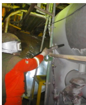
Nízkoprašné abrazivní otryskávání technologií Sponge-Jet
